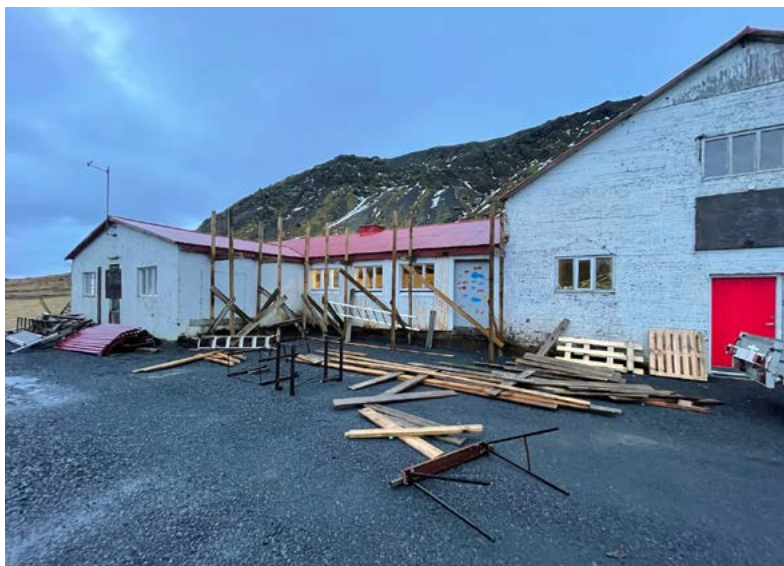
Framkvæmdir við útihús í Alviðru.
